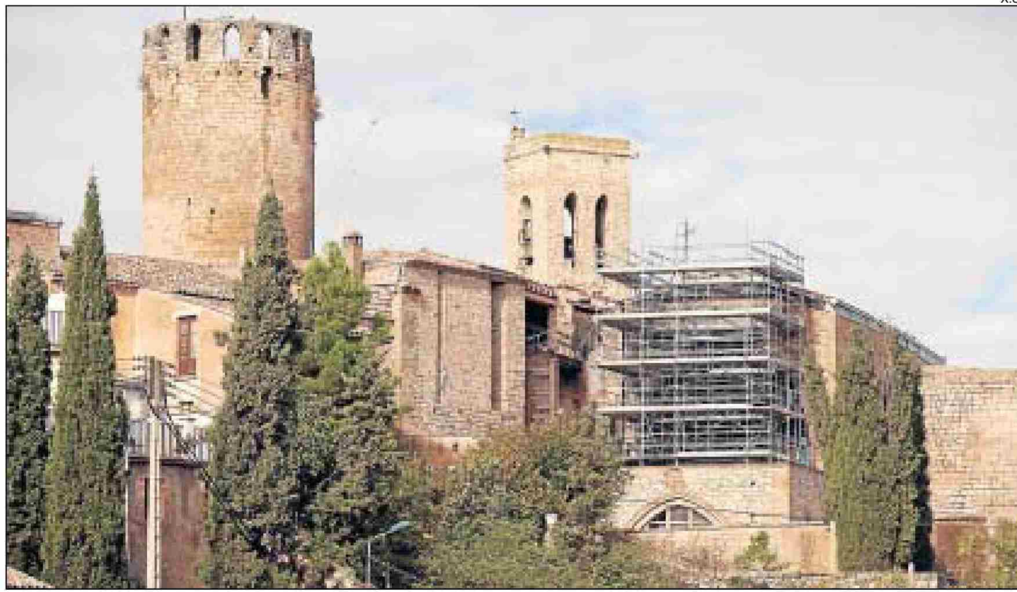
Les obres de rehabilitació es centren ara a la planta noble.
